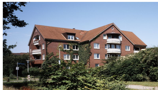
(Bsp. eines Hauses der Wohnanlage)
