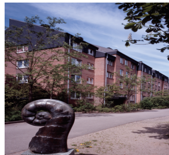
(Bsp. eines Hauses der Wohnanlage)
