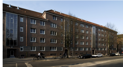
(Bsp. eines Hauses der Wohnanlage)
