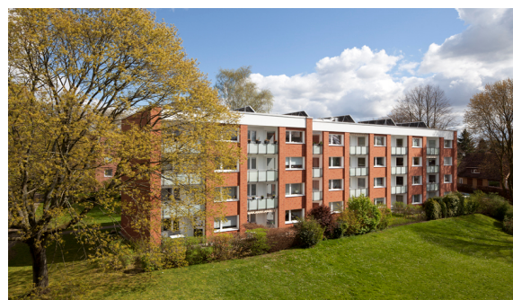
(Bsp. eines Hauses der Wohnanlage)
