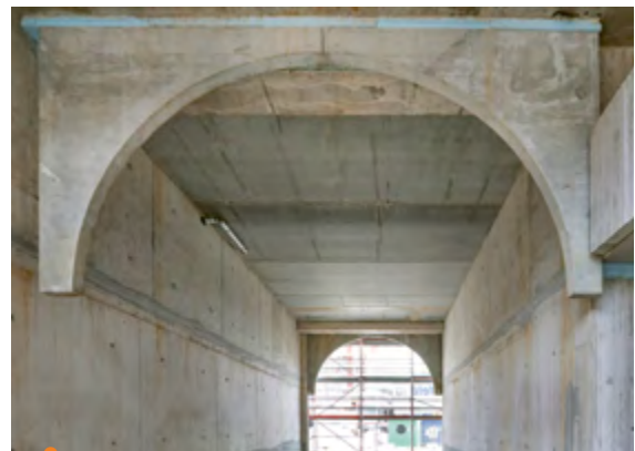
Im Pergolenviertel geht es im Großen wie in den Details der Haustechnik weiter.
