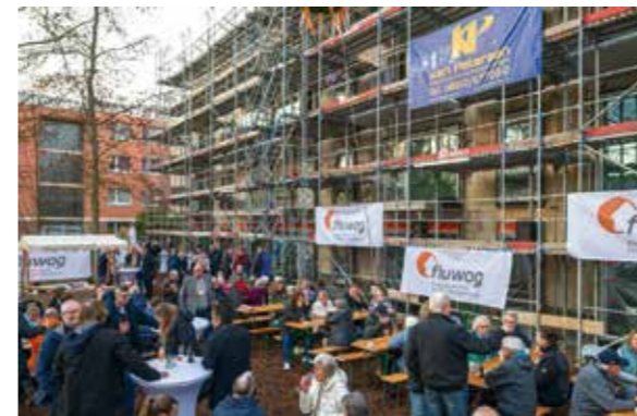
Voll im Zeitplan: Der Rohbau des Hauses C konnte wie geplant im Februar fertiggestellt werden.
