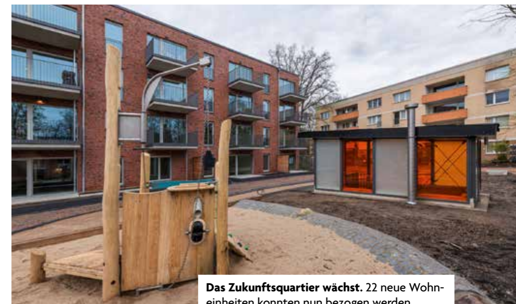
Bereit für Bewegung und Erholung: Trimm-dich-Pfad, Wege und Sitzgelegenheiten sind bereits fertiggestellt.
