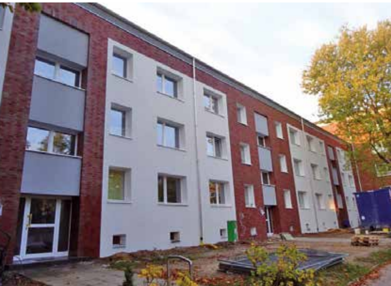
Die neue Fassade unserer Wohnhäuser im Harnackring 14–18 im Oktober 2015 vor der Fertigstellung der Außenanlagen
