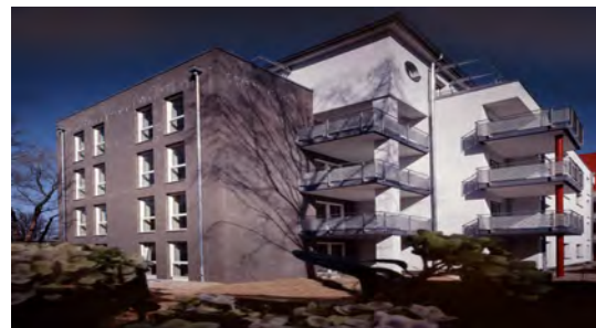
(Bsp. eines Hauses der Wohnanlage)
