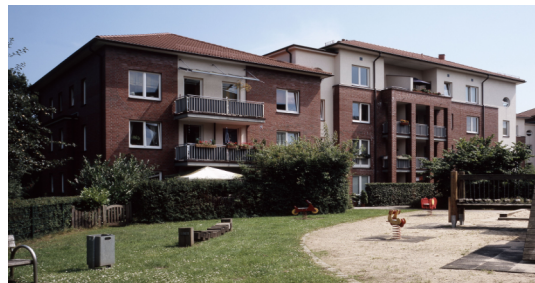
(Bsp. eines Hauses der Wohnanlage)
