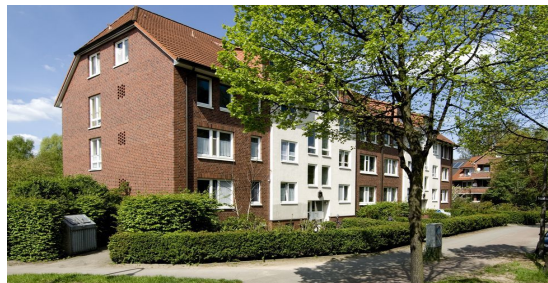
(Bsp. eines Hauses der Wohnanlage)
