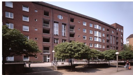
(Bsp. eines Hauses der Wohnanlage)
