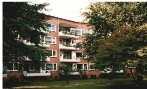
(Bsp. eines Hauses der Wohnanlage)
