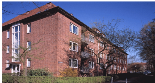
(Bsp. eines Hauses der Wohnanlage)
