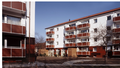
(Bsp. eines Hauses der Wohnanlage)
