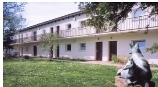
(Bsp. eines Hauses der Wohnanlage)
