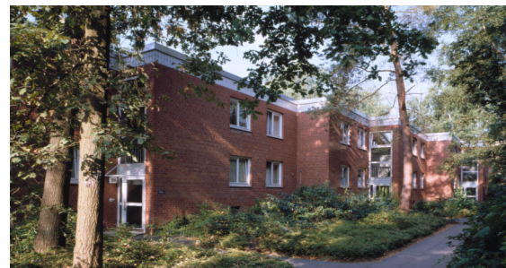
(Bsp. eines Hauses der Wohnanlage)
