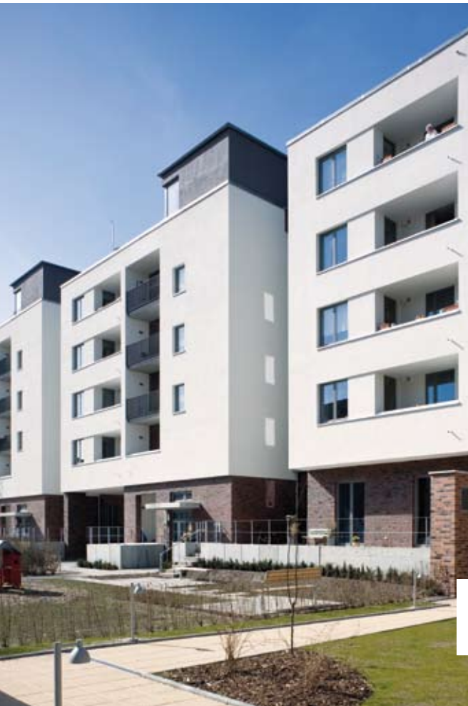
Hofansicht Seniorenwohnungen mit Service Saarlandstraße 22–24
