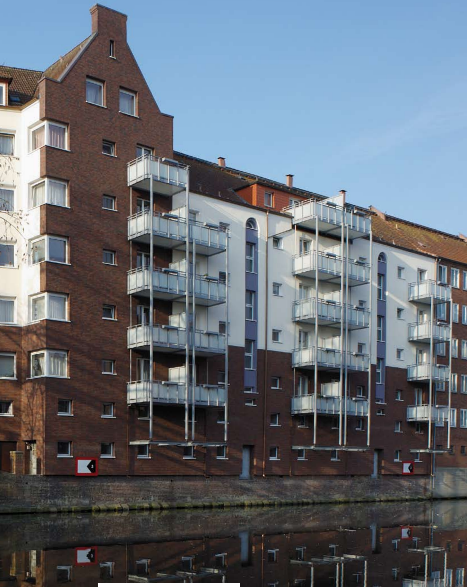
Osterbrook 20 a-c, Hamm-Süd Errichtung vorgehängter Balkone über dem Mittelkanal
